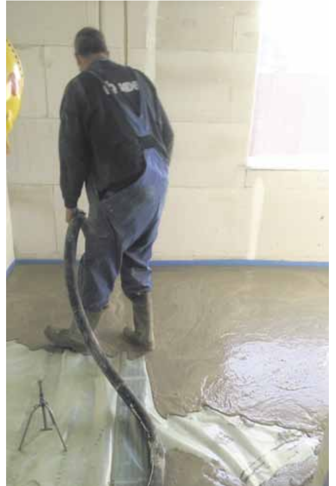
Arbo-technische redenen waren doorslaggevend voor de keuze van gietdekvloeren.
