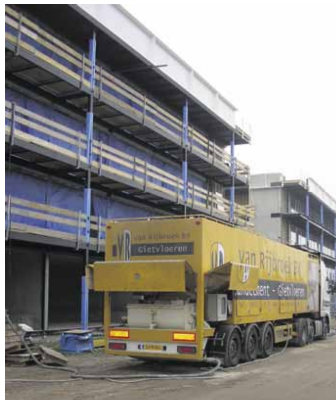
Van Rijbroek heeft eigen mobiele gietmortelcentrales. Het aanmaken van de mortel gebeurt op de bouwplaats zelf.
