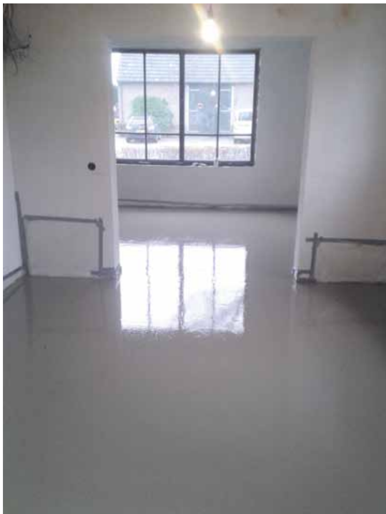
De woning in Bergeijk is grondig gerenoveerd en uitgebouwd, zodat een totale vloeroppervlakte is ontstaan van 240 vierkante meter.
