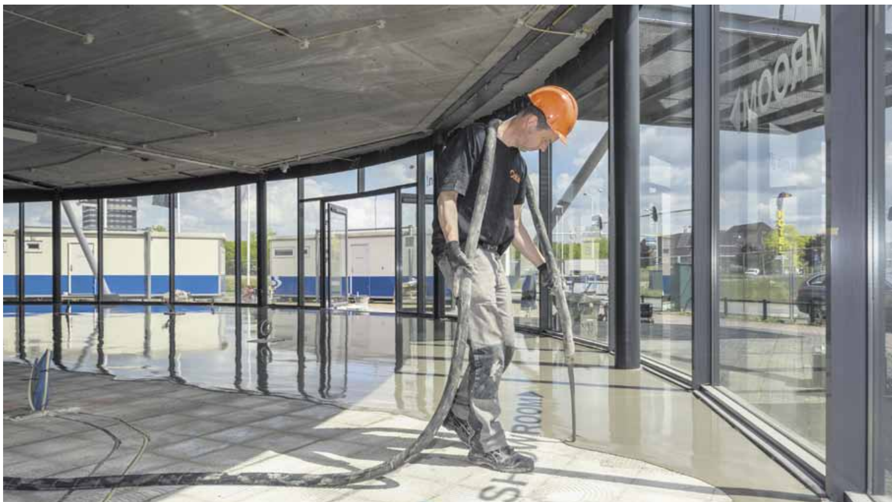
De vloeren van de autoshowroom in Assen worden door M2 vloeren grondig gerenoveerd.
