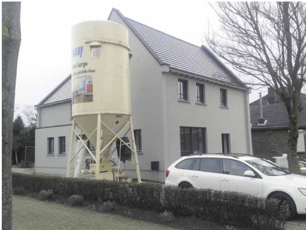
Voorgemengde mortel wordt in droge vorm aangeleverd op de bouwplaats. De silo's hebben een maximale inhoud van 22 kuub, daarom leent deze werkwijze zich goed voor kleinere projecten.
