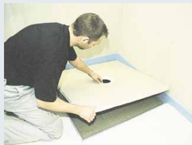
Weliswaar werken op de knieën, maar door de snelle en eenvoudige plaatsing van de elementen is de fysieke belasting minimaal.
