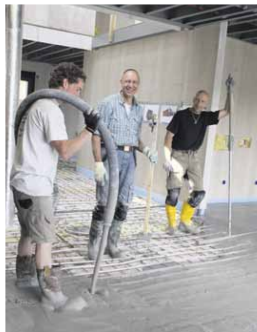
Tijdens de bouw waren de arbeidsomstandigheden een belangrijk aandachtspunt.
